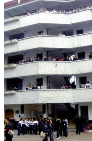
Das Gebäude der Partnerschule in China – fotografiert vom Innenhof der Schule aus.
