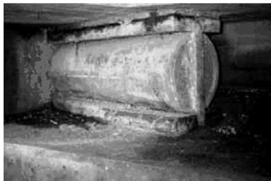
Rollenlager einer Brücke mit beginnender Korrosion
