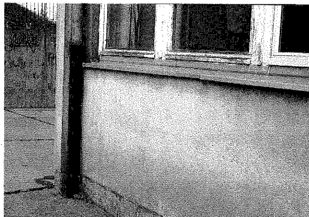
Die Außenwand erfüllt die Forderungen der Wärmeschutzverordnung 1982 zu 50 %.
