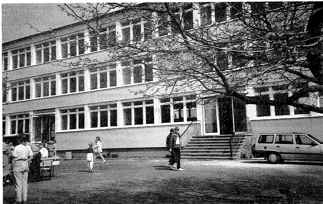
Schillerschule in Riesa, 1991 saniert
