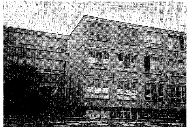
Fachklassengebäude (Trakt B) mit den bauweisenbedingt quergelagerten Fachklassenräumen für Naturwissenschaften, Musik und Werken, der Hausmeisterwohnung und den WC-Anlagen. Die tiefen Raumzuschnitte haben ungünstige Belichtungs- und Belüftungsbedingungen zur Folge.
