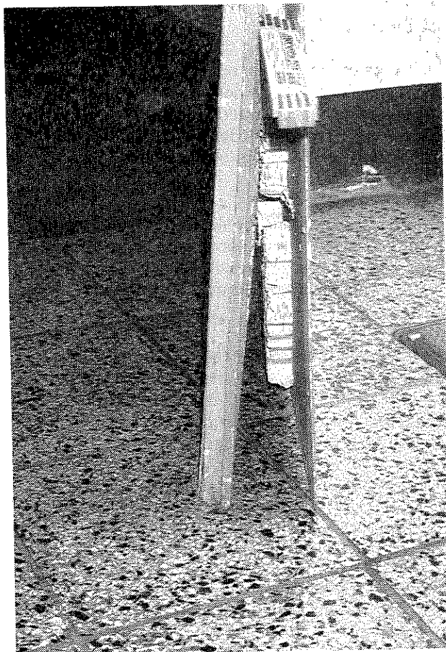
Als Klassenraumtüren wurden (Wohnungsbau-) Normtüren aus Holzwerkstoffen mit im Wandelement eingebauter Stahlzarge verwendet.
