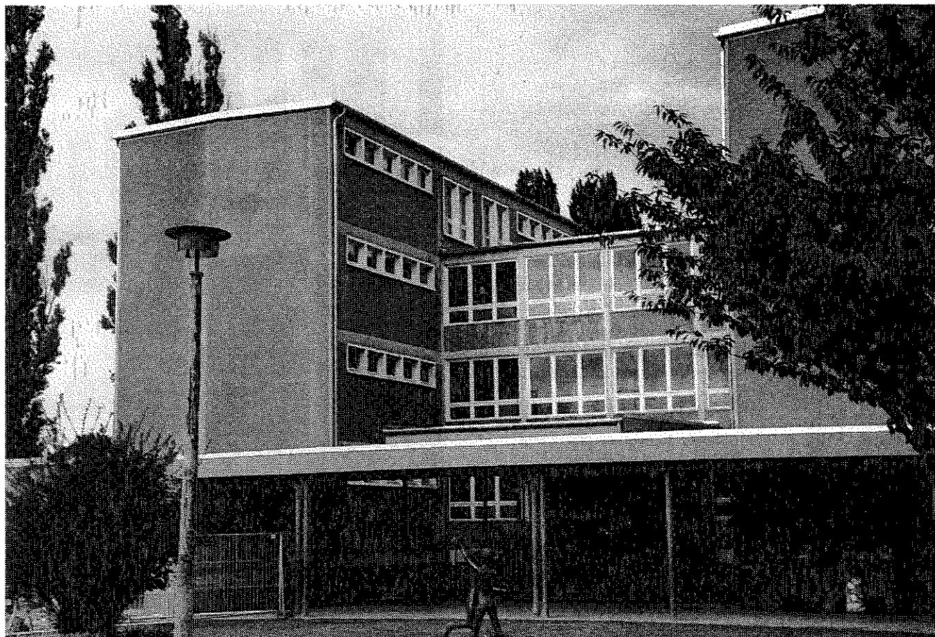
Giebelansicht der Schule mit Verbindungsbauten
