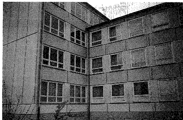
Unterrichtstrakt mit 3geschossigem Verbindungsbau
