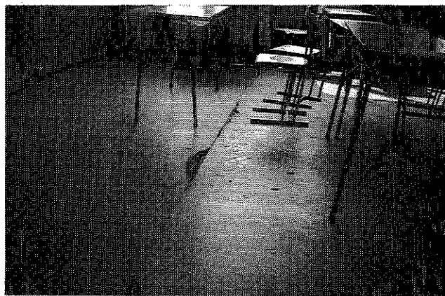
verschlissene PVC-Fußbodenbeläge
