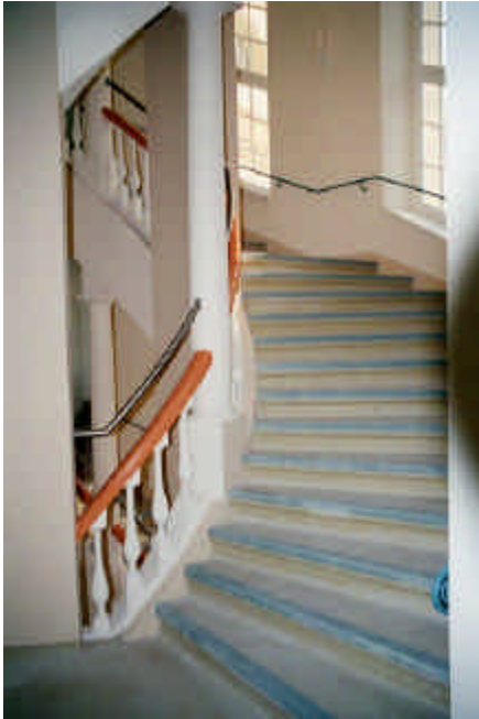
Wendeltreppe im Turmschaft
