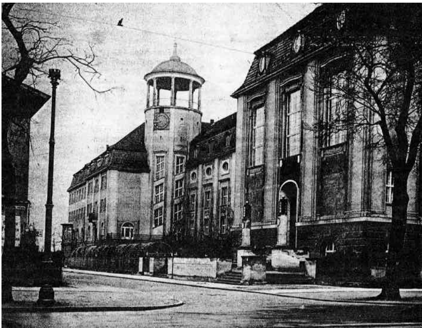
Ehemalige Staatliche Handels- und Gewerbeschule zu Potsdam - Aufnahme vor der Zerstörung 1945 -
