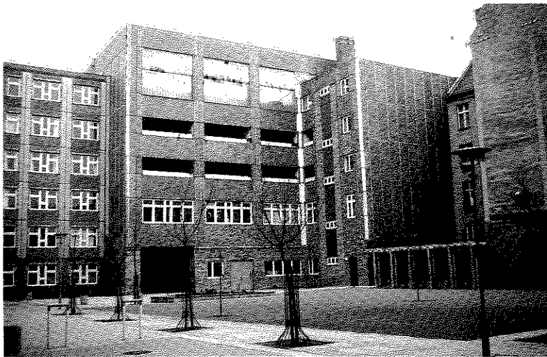
Wilhelm-Thiele-Oberschule, Berlin 1988 Innerstädtische Baulückenschließung in Großtafelbauweise
